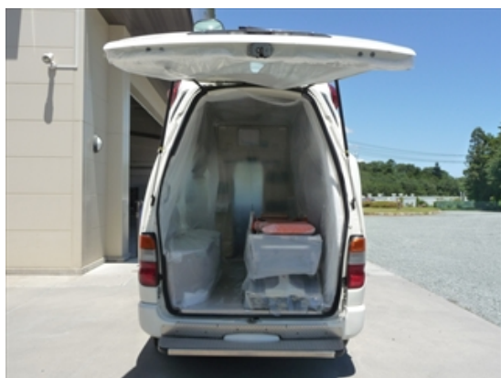
③天井及びハッチの養生
