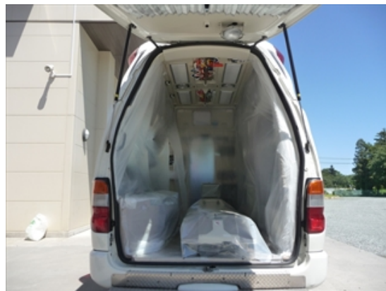
②側面の養生（両側）
