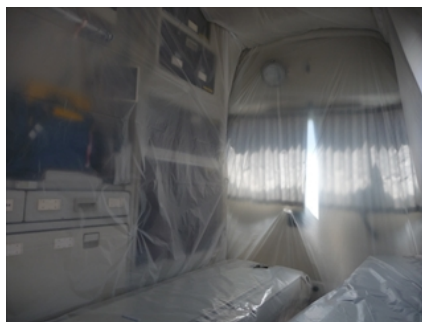
④使用資機材にはカッター等で露出させておく。
