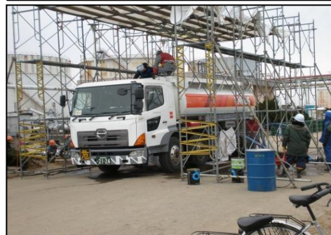
屋外タンクから移動タンク貯蔵所に危険物を移し替えている様子
