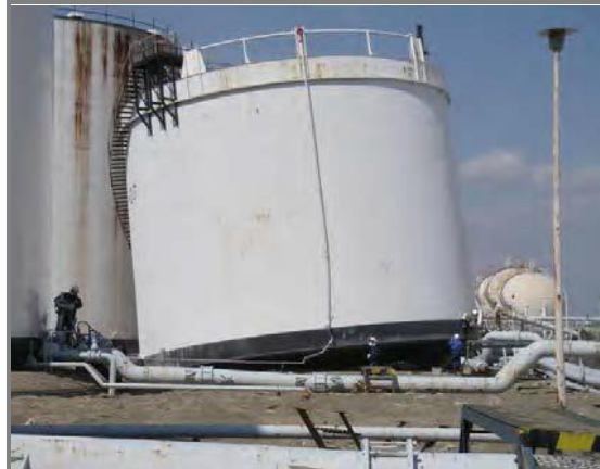
津波により浮上・移動したタンク (地震時は空) (出典：消防研究センター)
