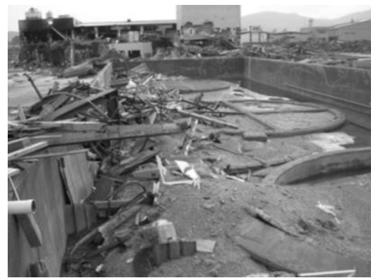
津波によりタンクが移動した タンクヤード (出典：消防研究センター)
