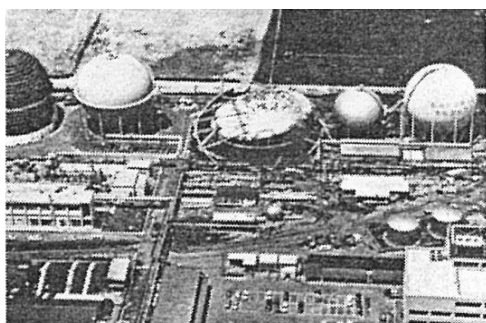
屋外貯蔵タンクの傾斜
