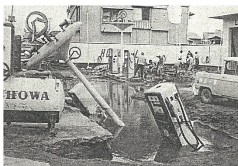
信濃川の逆流により被害を受けた給油取扱所
