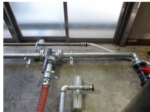
泡水溶液ー水の切換用三方弁
