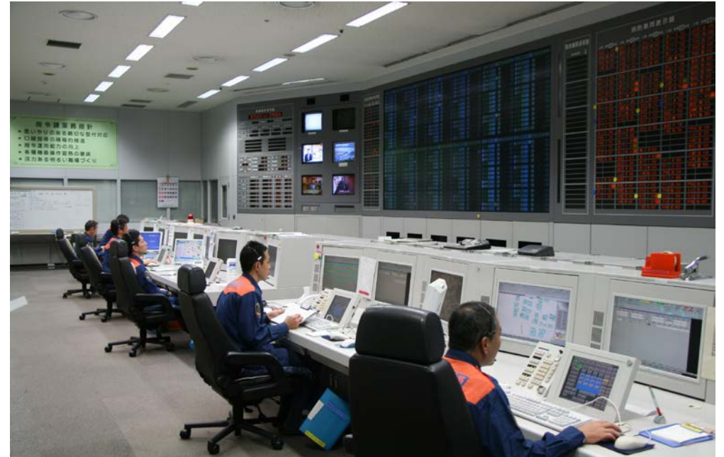
北九州市消防局 指令センター
