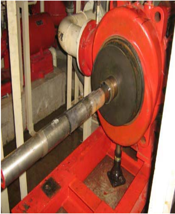
中間ケーシングの取外し
