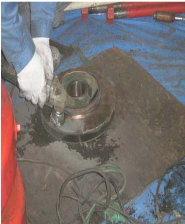
羽根車を電動機器によりケレン中
