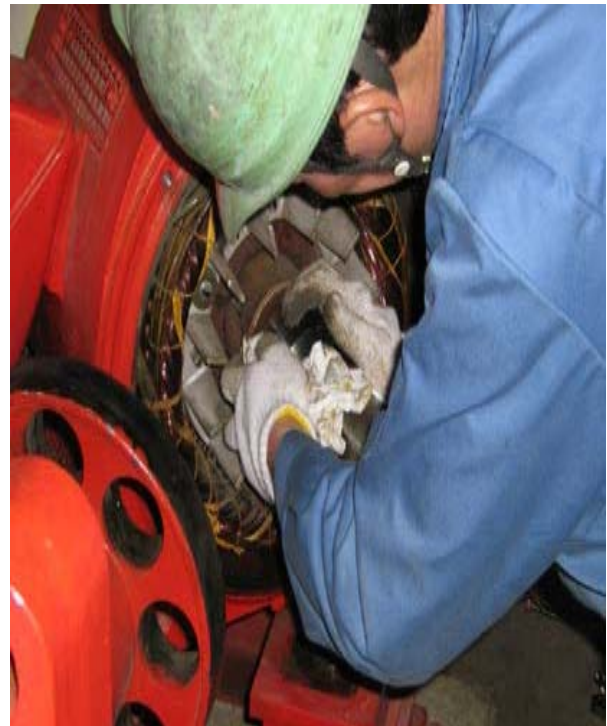
モーター部主軸部のベアリング取外し中
