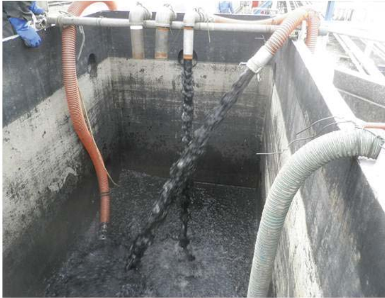
写真4-4 配管内洗浄時の状況(1)
