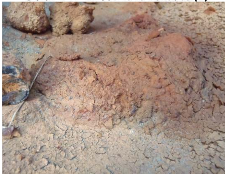
写真3-5-1 配管内面凸状部分(1)
