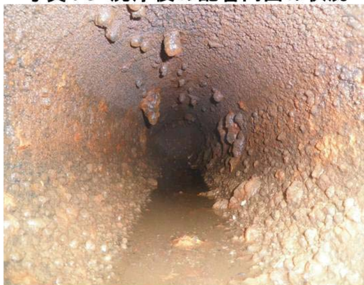
写真4-6 洗浄後の配管内面の状況
