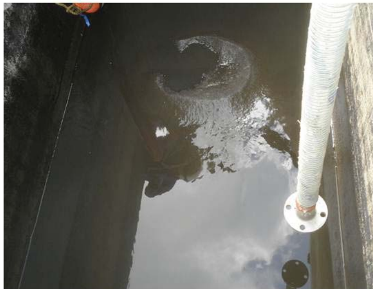
写真4-5 配管内洗浄時の状況(2)
