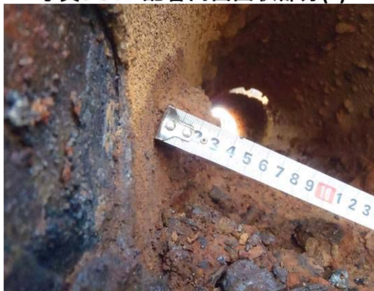
写真3-3-2 配管内面凸状部分(2)
