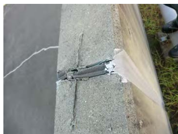
目地部の損傷による補修例（コーキング剤）
