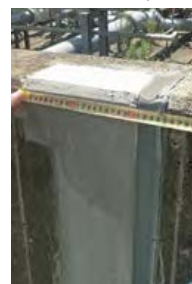
目地部の損傷による補修例（コンクリート打ち替え）
