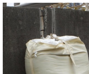
目地部の応急処置例（フレコンバック）
