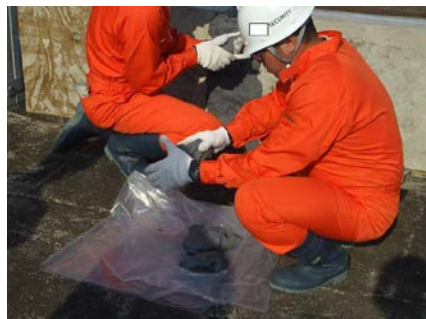
図 不乾性パテ設置状況
