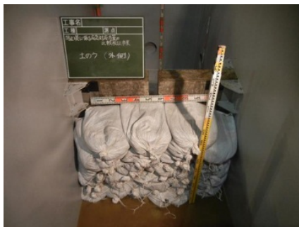
図 土のう(外側)設置状況
