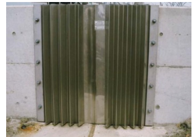
ステンレス製可とう性材の設置例
