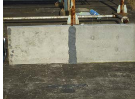
図 不乾性パテ設置後
