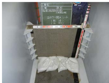
図 防水シート(乾燥、外側)設置状況
