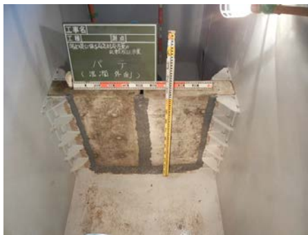
図 不乾性パテ(湿潤、外側)設置状況
