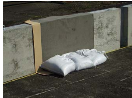
図 防水シート設置後
