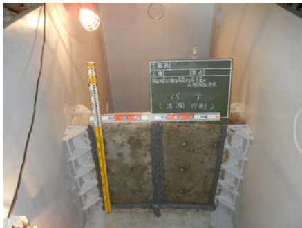
図 不乾性パテ(湿潤、内側)設置状況
