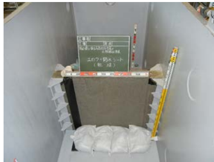
図 防水シート(乾燥、内側)設置状況
