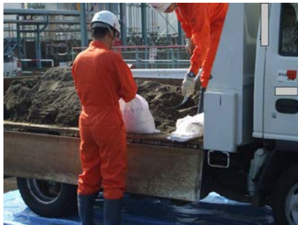
図 土のう作成状況
