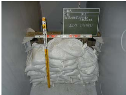
図 土のう(内側)設置状況
