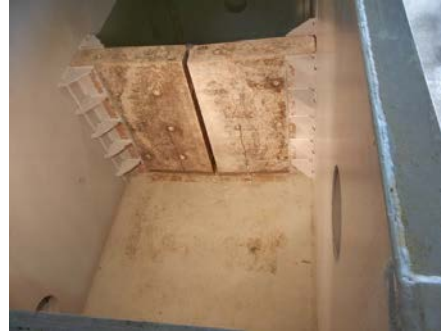
図 不乾性パテ(乾燥、内側) 水圧試験状況
