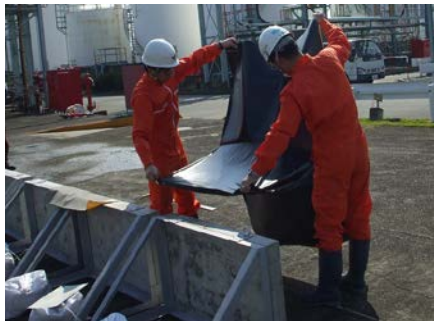
図 防水シート設置状況
