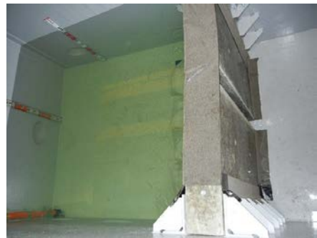
図 防水シート(乾燥、内側)水圧試験状況
