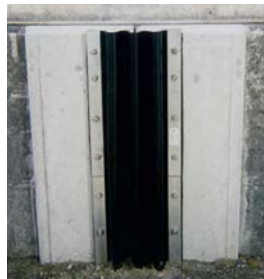
ゴム製可とう性材の設置例
