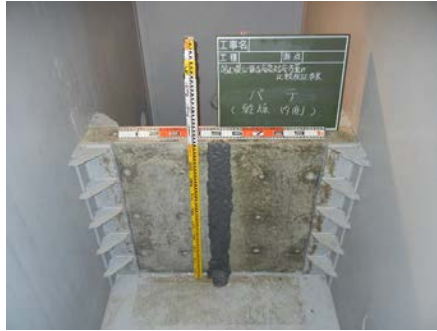
図 不乾性パテ(乾燥、内側)設置状況
