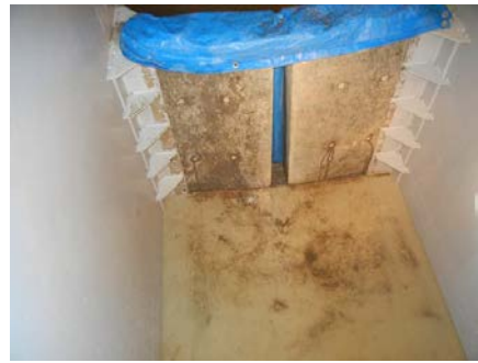
図 土のう(内側、ブルーシート併用)水圧試験状況
