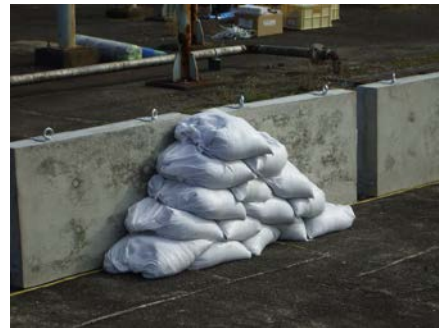
図 土のう設置状況
