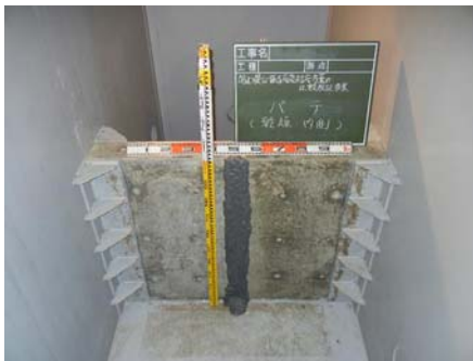
図 不乾性パテ(乾燥、内側)設置状況
