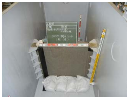
図 防水シート(乾燥、内側)設置状況
