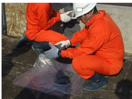
図 不乾性パテ設置状況
