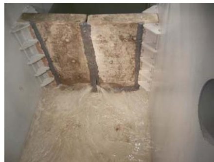
図 不乾性パテ(湿潤、外側) 水圧試験状況
