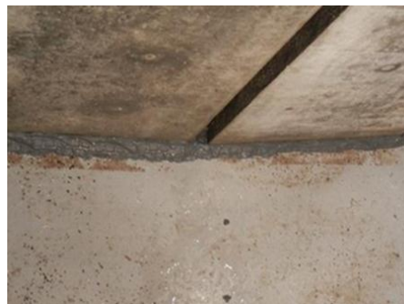
図 不乾性パテ(湿潤、内側) 水圧試験状況
