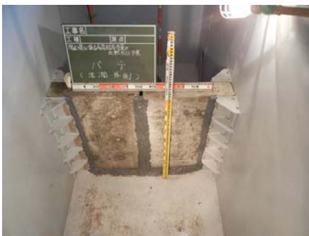
図 不乾性パテ(湿潤、外側)設置状況
