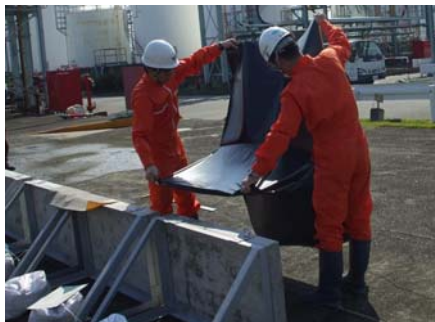
図 防水シート設置状況
