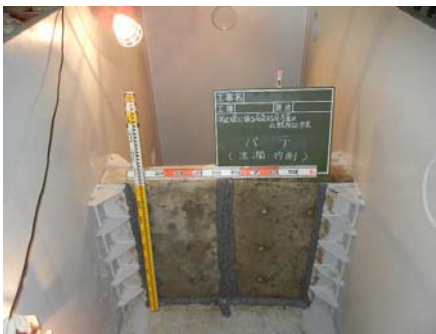
図 不乾性パテ(湿潤、内側)設置状況
