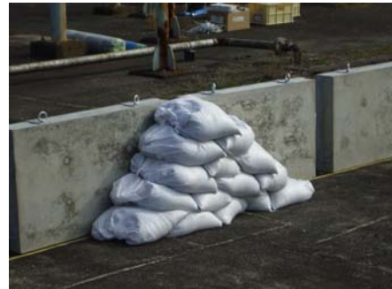
図 土のう設置状況
