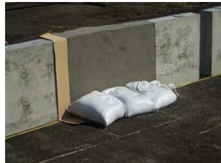
図 防水シート設置後
