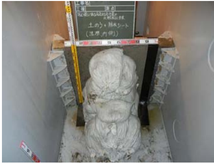
図 防水シート(湿潤、内側、土のう併用)設置状況
