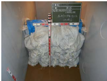
図 土のう(内側、ブルーシート併用)設置状況
