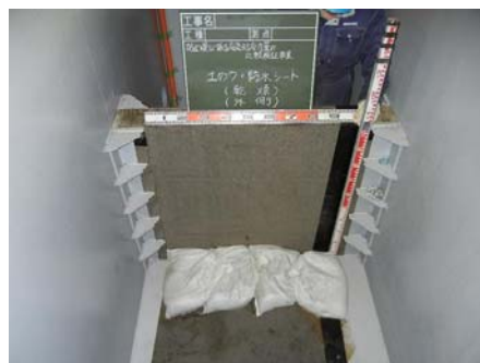
図 防水シート(乾燥、外側)設置状況
