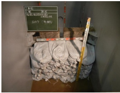
図 土のう(外側)設置状況
