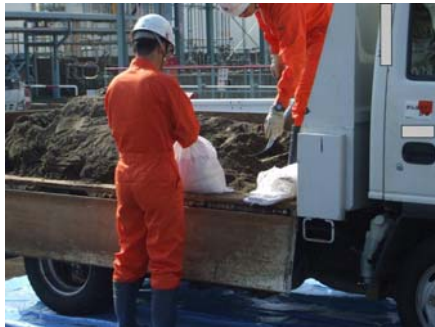
図 土のう作成状況
