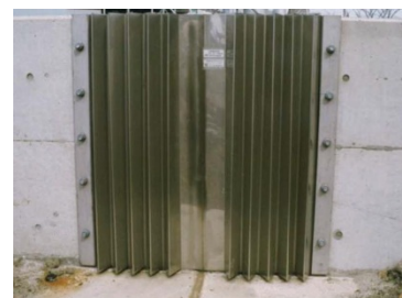
ステンレス製可とう性材の設置例
