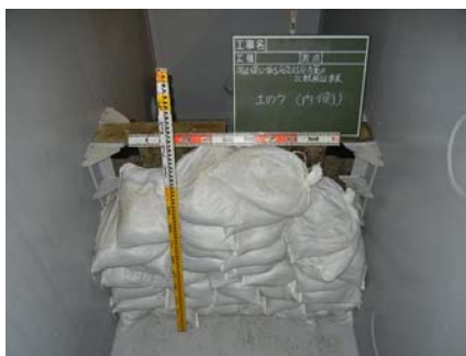
図 土のう(内側)設置状況
