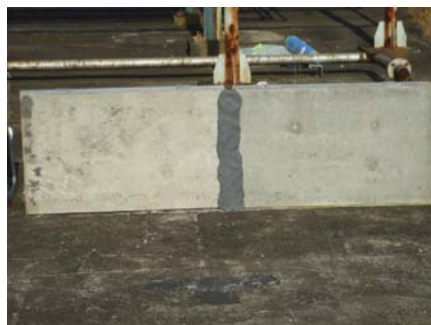
図 不乾性パテ設置後
