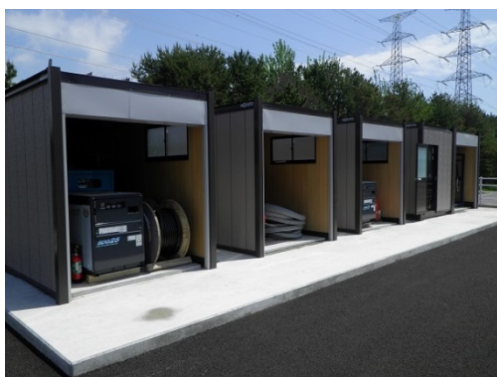
写真 2-5 高台に設けた非常用資材庫
