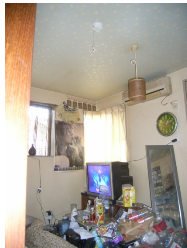
写真1 出火室の状況
