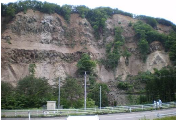
■6 月 14 日 現場全景を北東側より撮影
