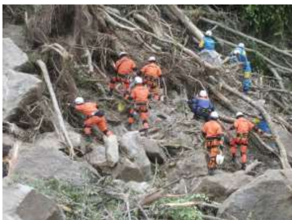
■6 月 17 日 崩落箇所検索状況
