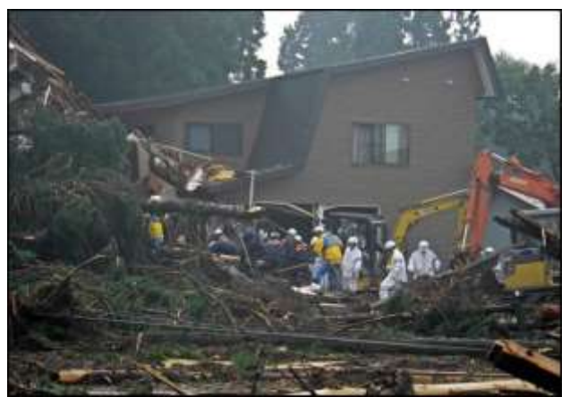
重機を使用した検索活動
