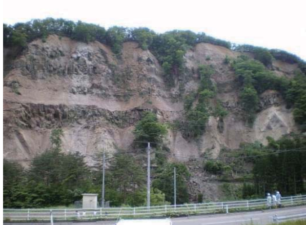
■6月14日 現場全景を北東側より撮影
