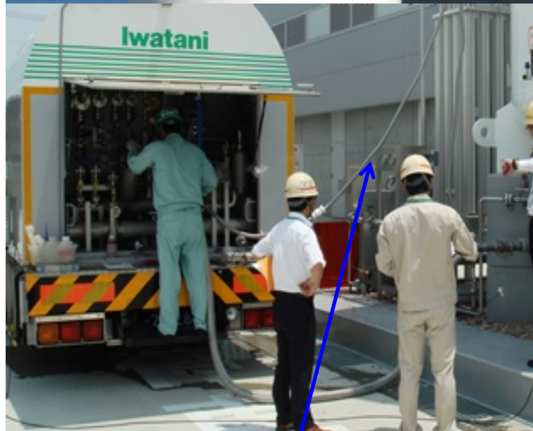
ローリー放出管をスタンド内のベント放出管に接続
