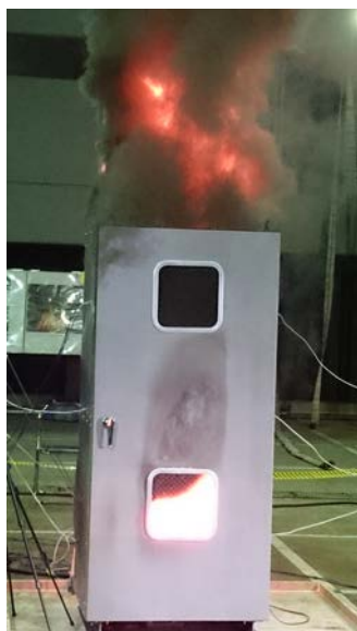
鉛蓄電池延焼状況⑤
