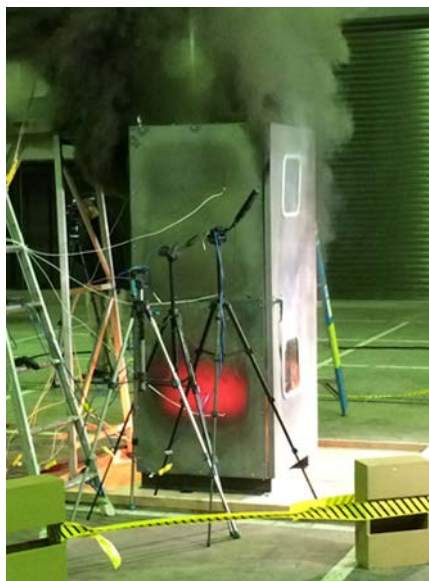
鉛蓄電池延焼状況④
