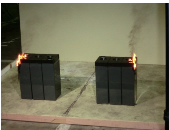
充電状態電池 放電状態電池
