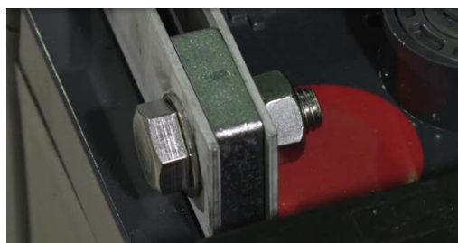
端子接続部（緩めた状態）
