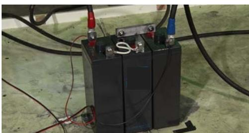
8 mm<sup>2</sup>の電線による接続
