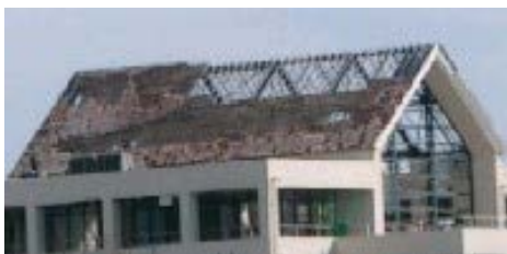
図4 台風で屋根の一部が吹き飛んだ工場
