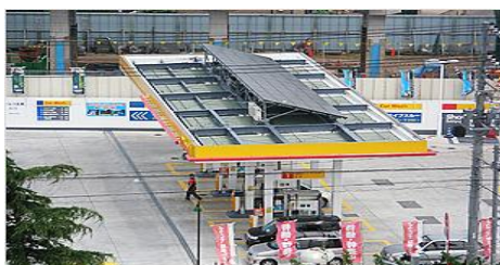
図2 給油取扱所での設置事例（約4KW）
