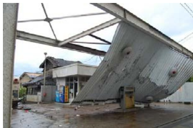
図5 竜巻で折半屋根が脱落したガソリンスタンド
