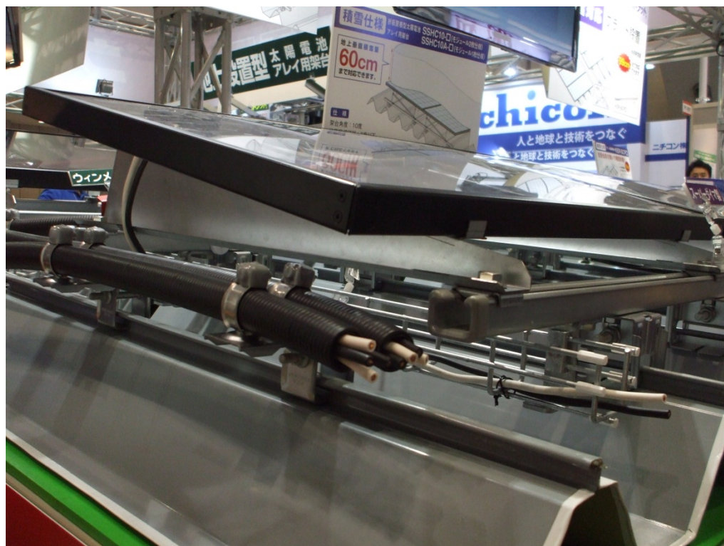
写真 2 ハゼ式折板屋根と電気配線の固定状況（A社の金具による）
