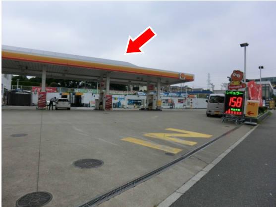
写真 1 給油所全景。キャノピー上に太陽電池モジュールが設置されている。
