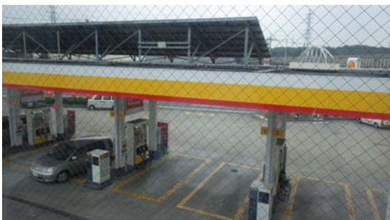
写真 4 キャノピー上の太陽電池モジュールを販売室の 2 階から撮影。
