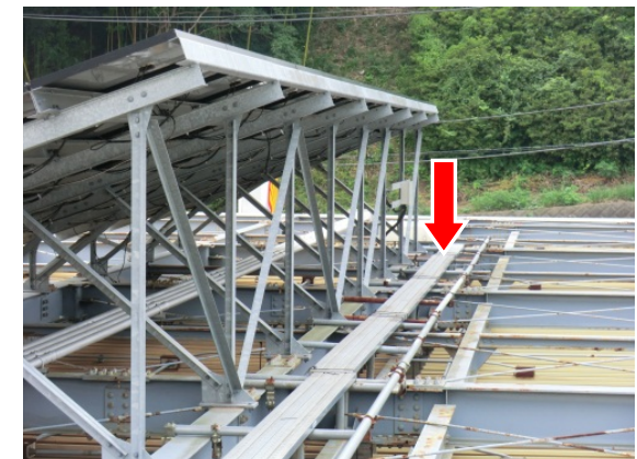
写真 8 キャノピー上に設けられた足場
