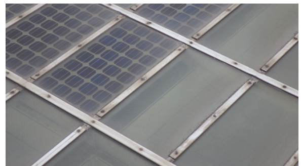
写真 23 太陽電池モジュールと網入りガラス ○太陽電池モジュール 発電セルをガラスではさんだ構造のもので、全体の厚さは10mm。 ○網入りガラス 太陽電池モジュールの周囲に設けられている。厚さは6mm。
