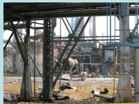
三井化学(株)岩国大竹工場製造施設爆発火災事故
