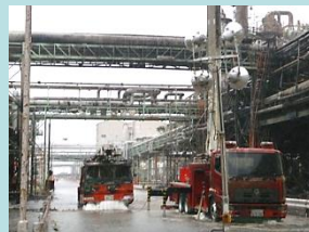
(株)日本触媒姫路製造所爆発火災事故
