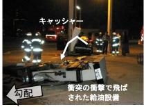
走行中の自動車が、運転操作の 誤りにより、道路に面した給油取 扱所に突っ込んで給油設備に衝 突した。この衝撃で給油設備が飛 ばされ、内部に停滞していたガソ リン等の危険物が幅2m、長さ10m の範囲に流出・拡散したもの。な お、事故発生当時、この給油取扱 所は営業していなかった。(H20)
