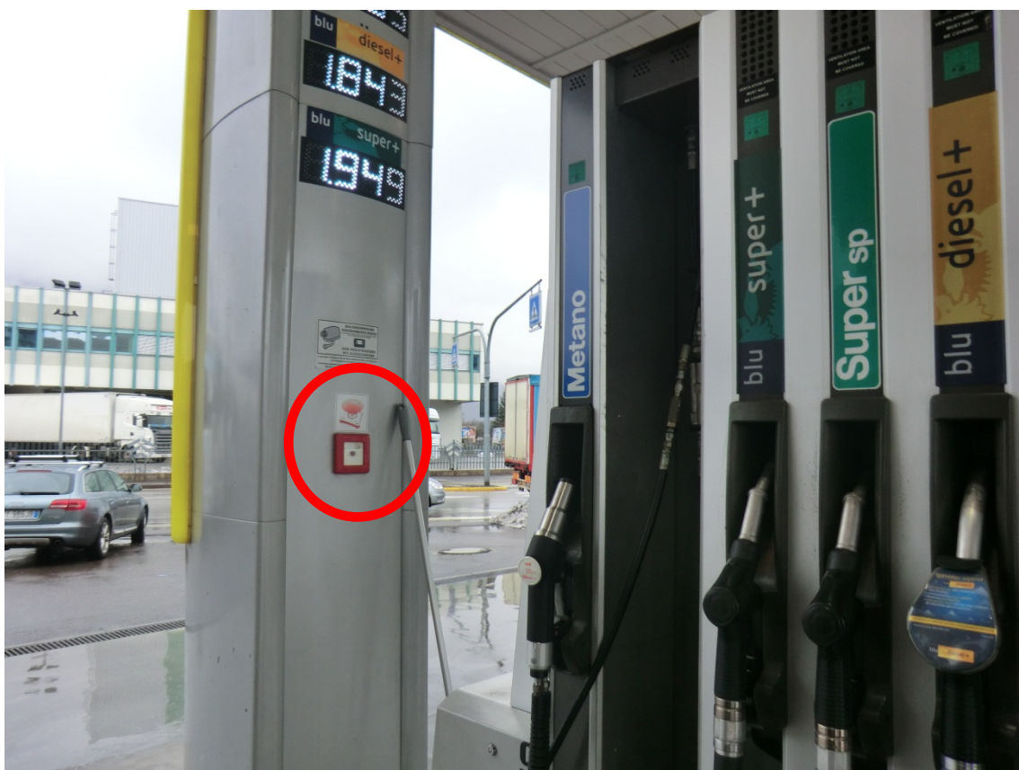
マルチディスプレイの近くに設置された緊急停止ボタン
