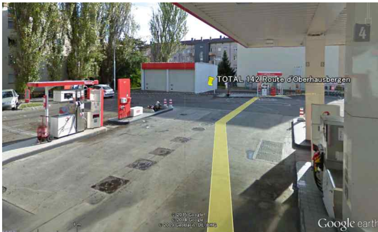
写真 1 フランス東部 ストラスブール郊外の併設給油取扱所（左側が CNG ディスペンサー） （出典：Google Earth Pro）（場所: 48. 35′ 44″ N 7. 42′ 33″ E）
