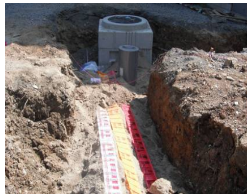
標識シート敷設例
