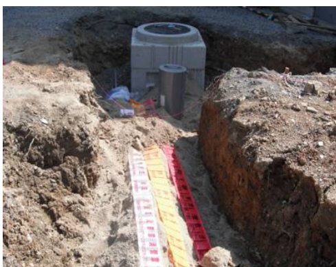
図 4 - 3 標識シート敷設例
