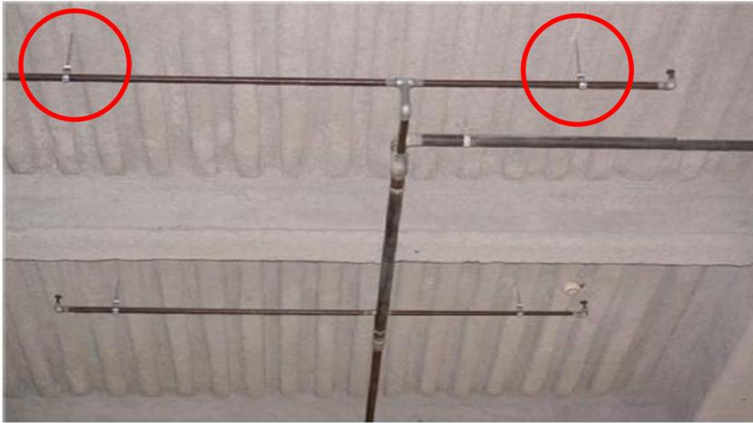
横引き配管の耐震支持の長さを短くすることにより振れを抑制できるため、出来る限り上階床スラブに近い位置で横引き配管を布設する。
