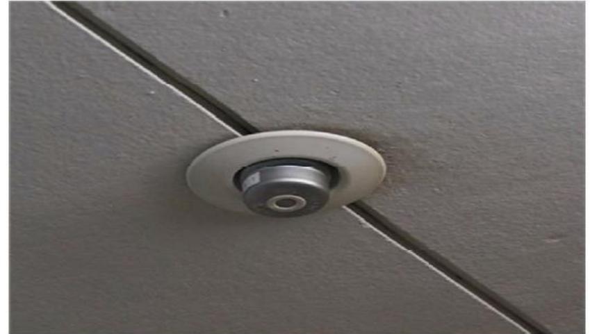
ヘッドの取付けは天井板など周辺部材と接触・衝突しないようにする。
