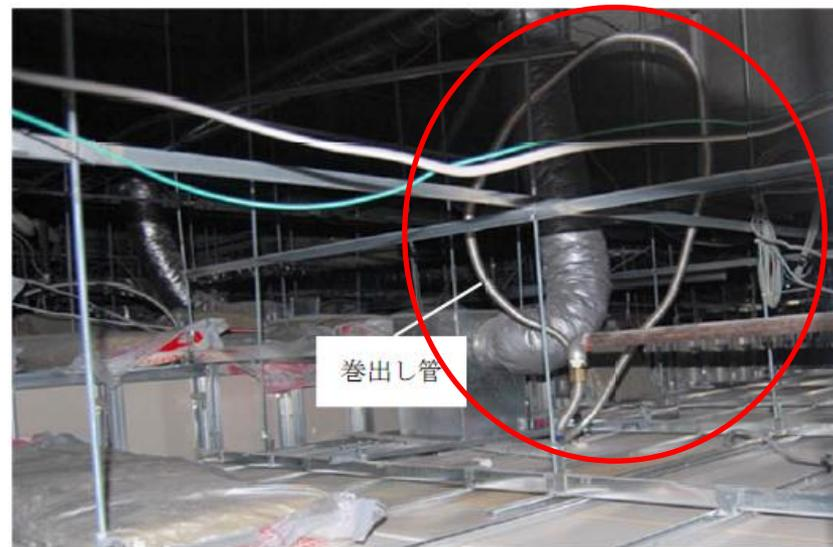
巻出し管は、揺れを想定して±200mm程度の変位に対応できる長さとし、長さが2.1mを超える場合は、中間支持を設ける必要がある。写真は、必要以上の長さで、中間支持を行っていない例。
