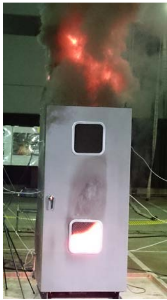
鉛蓄電池延焼状況⑤
