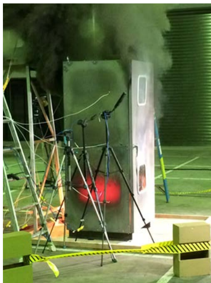
鉛蓄電池延焼状況④
