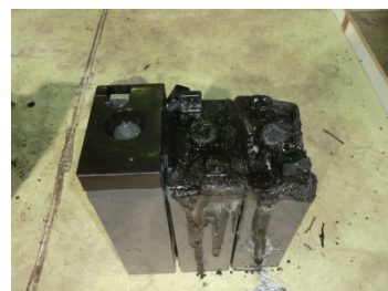
放電状態電池
