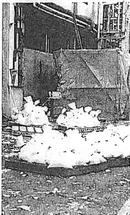
消火活動に使われた乾燥塩。乾燥塩約4トンの投入により今回の火災は鎮圧された。
