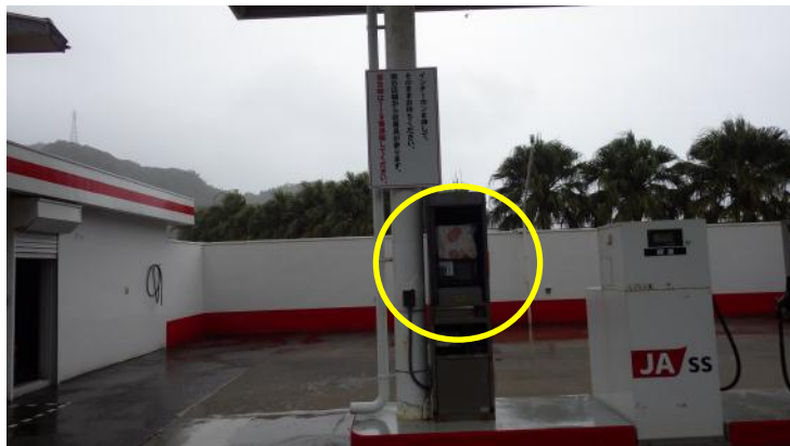
写真23 POS(給油取扱所に設置)
