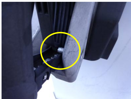
写真25・26 ノズルロック機能(給油取扱所に設置)
