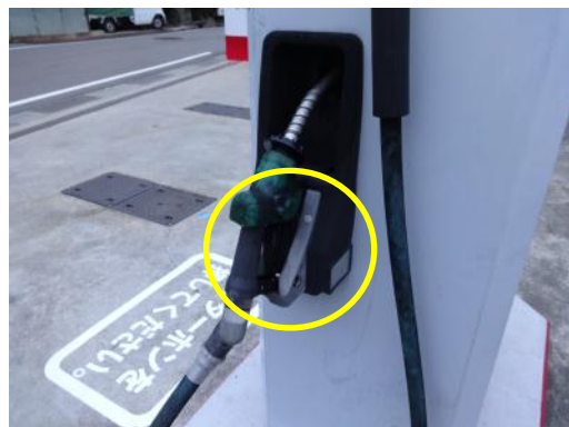
写真25・26 ノズルロック機能(給油取扱所に設置)
