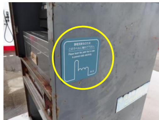
写真27 静電気除去シート(給油取扱所に設置)
