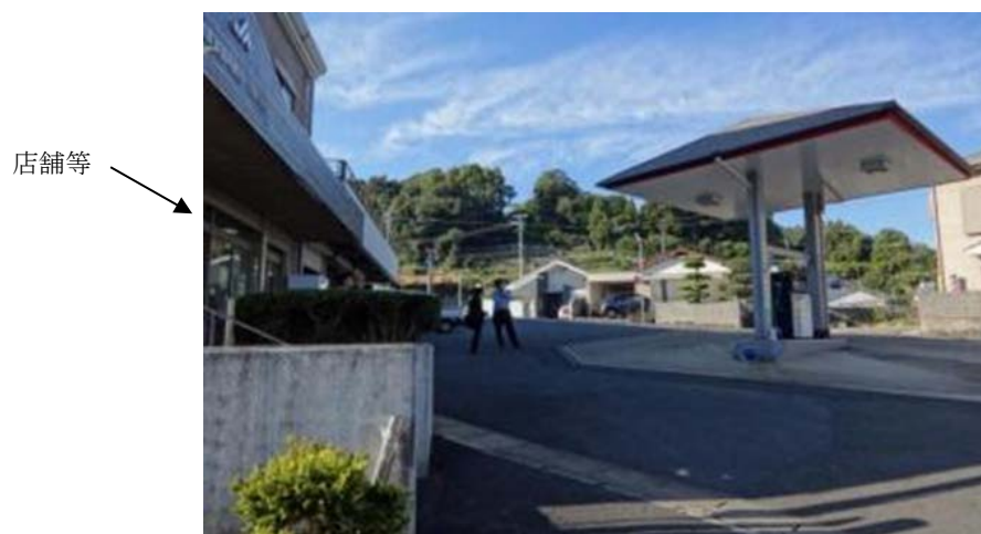
図 14 給油取扱所と店舗等が隣接している（構内道路あり／直視できる）
