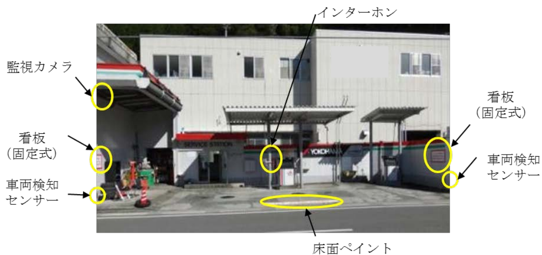
図9 機器等の設置場所
