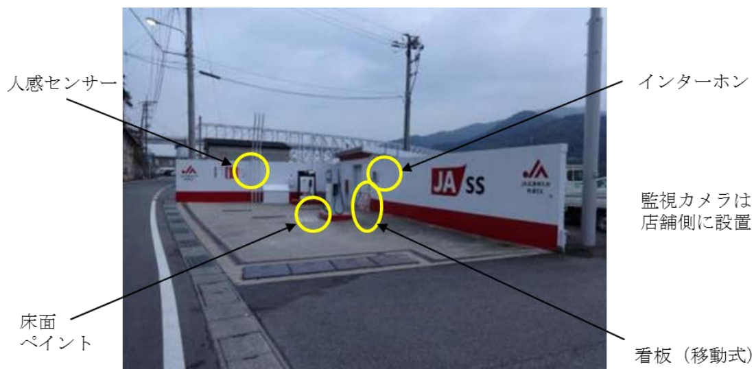
図 13 機器等の設置場所
