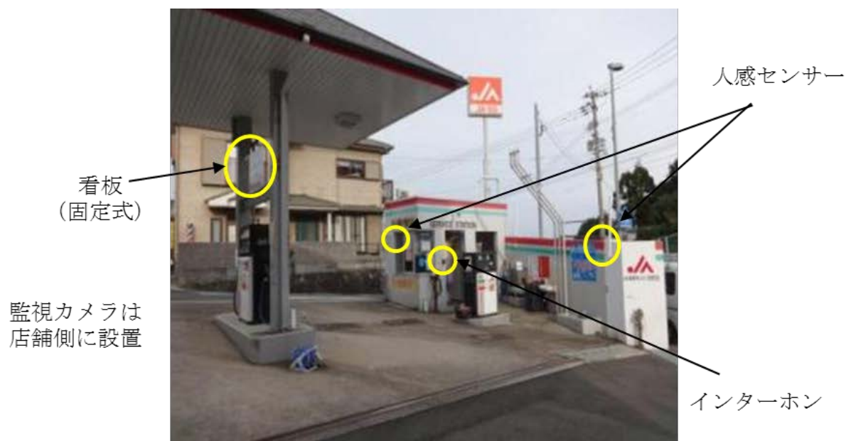
図 15 機器等の設置場所
