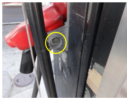
プッシュ錠によるノズルロックの状況
