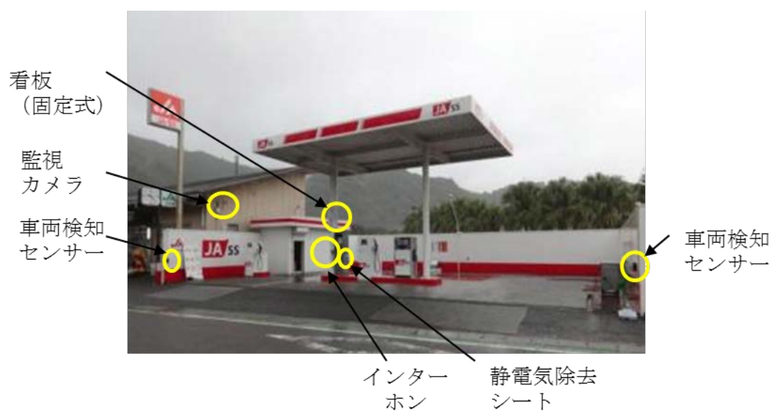
図 11 機器等の設置場所
