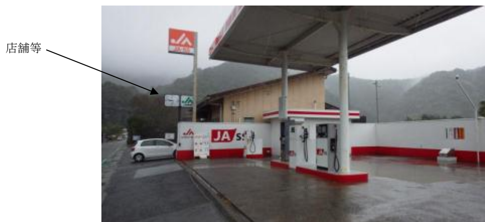
図 10 給油取扱所と店舗等が隣接している（直視できない）
