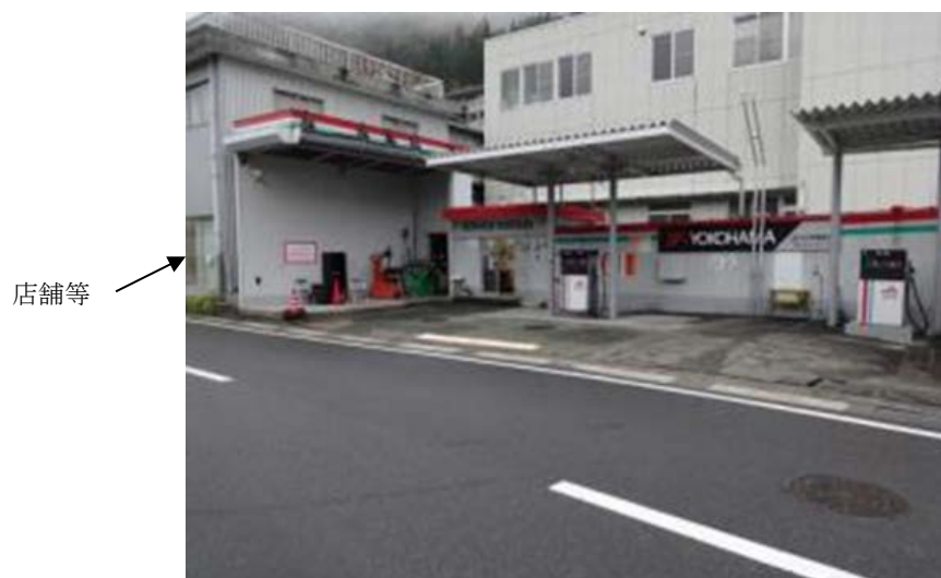
図8 給油取扱所と店舗等が隣接している（直視できない）
