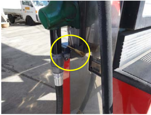
南京錠によるノズルロック状況
