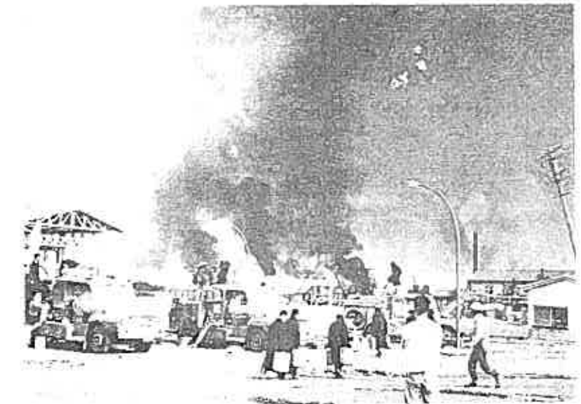
写真一3 化学消火剤の搬入作業
