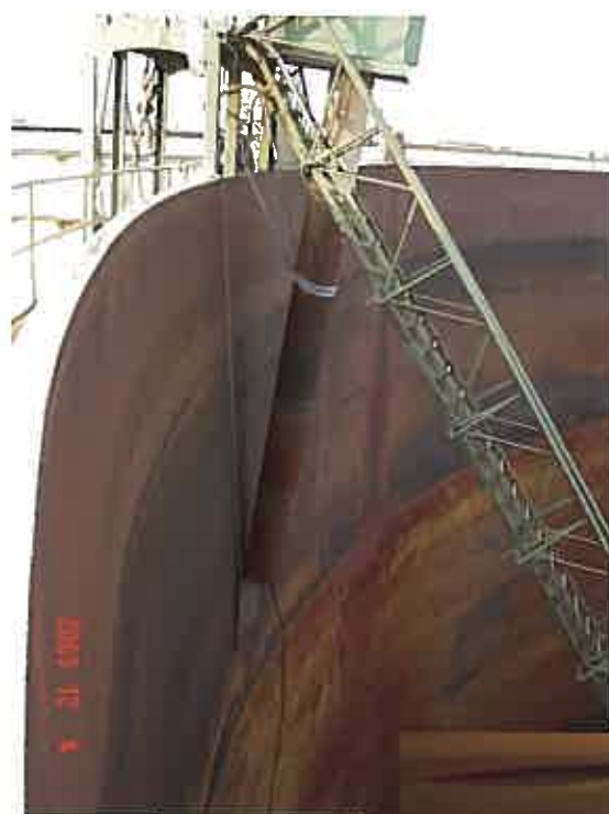
破断したゲージポール（上部）
