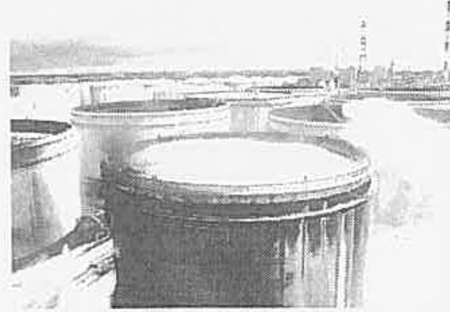
9:30頃 南側より撮影
