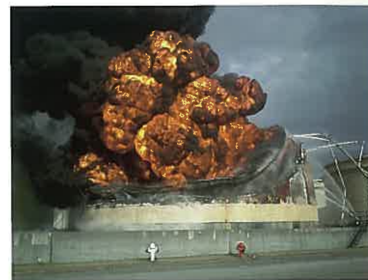
9/29 タンク西側から撮影【苫小牧消防本部撮影】
