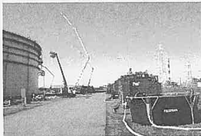
650番地区 #100651 タンク警戒状況(北面)
