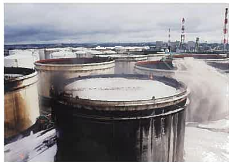
9:30 頃 タンク南側から撮影【苫小牧消防本部】
