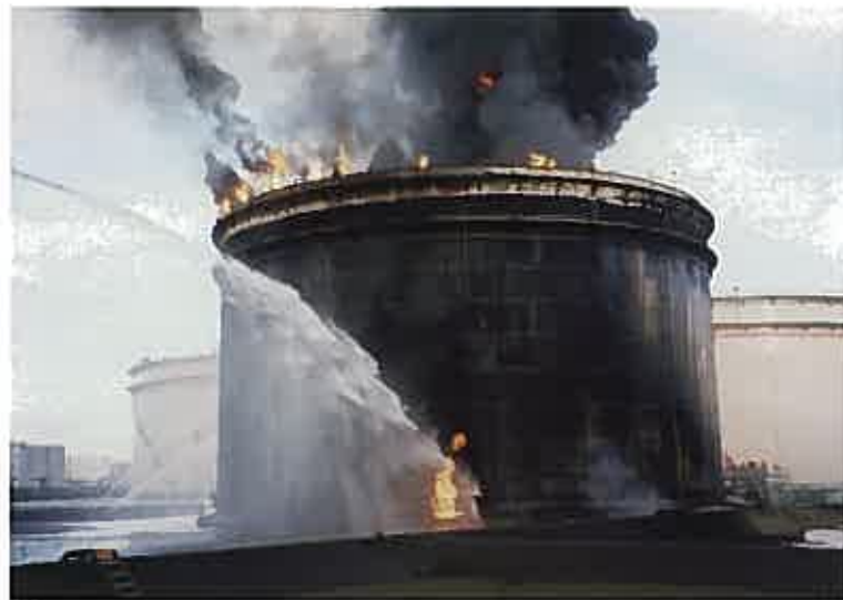
5:45～6:00 タンク東側から撮影【苫小牧消防本部】
