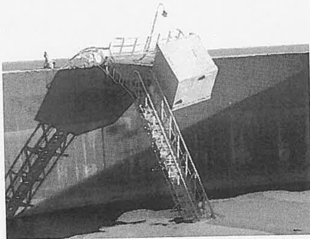
30063ナフサタンクの出火前の状況写真（出光撮影） ローリングラダーの角度から浮き屋根は底板に着底している模様
