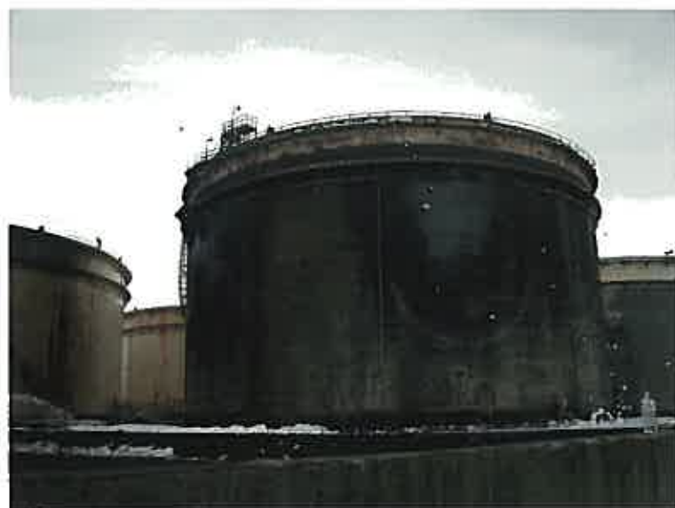
鎮火後の状態 タンク南側から撮影【苫小牧消防本部】
