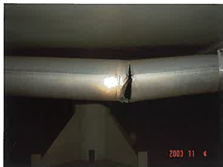
インナーフロートの損傷状況
