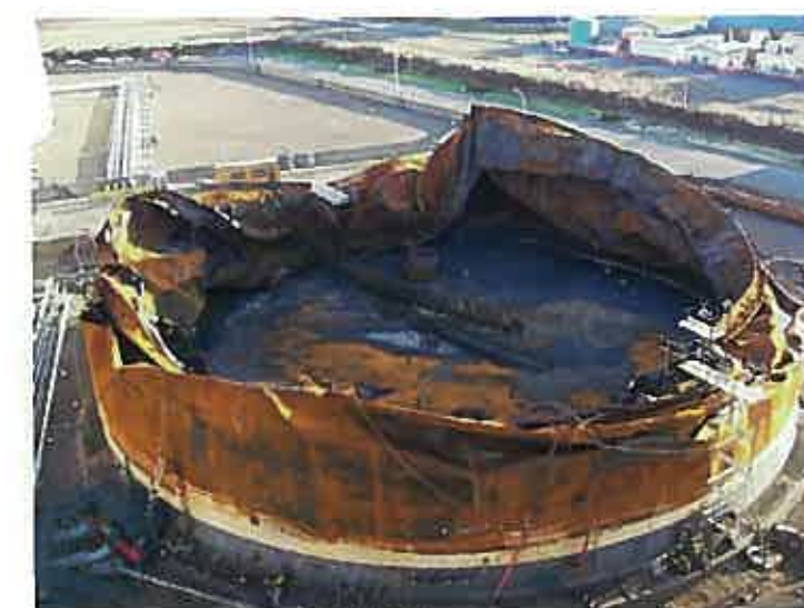
ナフサ抜き取り後のタンクの状況【消防研究所撮影】
