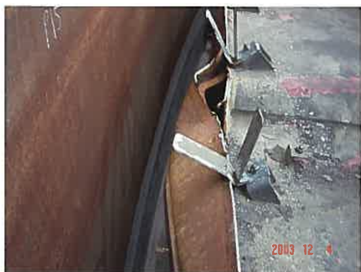
挫屈によるアウターリムとアッパーデッキとの隙間（外側）
