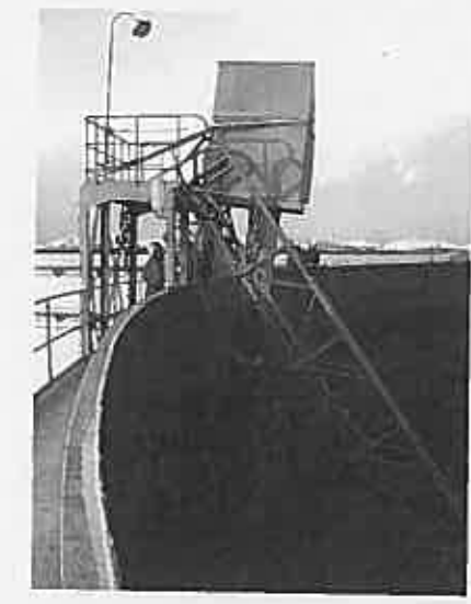
測定小屋、ゲージポールと共に内側へ10°傾き
