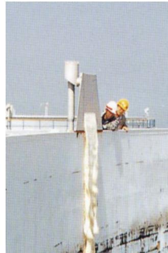
写真2 特型泡放出口からの泡放射状況
