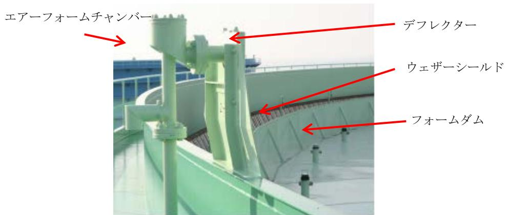
写真1 特型泡放出口の設置状況
