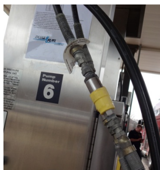
CNG ディスペンサーの緊急離脱カブラ
