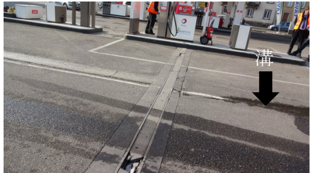
CNG ディスペンサーとガソリン等の給油取扱所の 間には傾斜、溝（10m程度離れている。）
