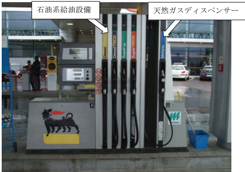
石油系燃料の給油設備と天然ガスのディスペンサーが一体となったマルチディスペンサー（ドイツ）（引用：日本ガス協会資料）
