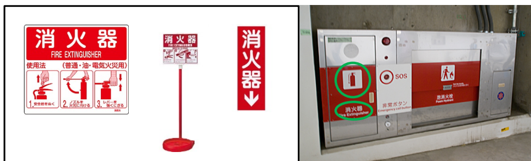
消火器の標識の例
