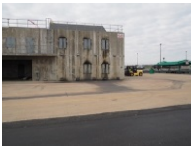
50建物燃焼訓練施設
