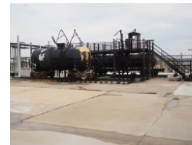
46レイルカー、導管ラック火災
