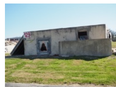
129一戸建て崩壊
