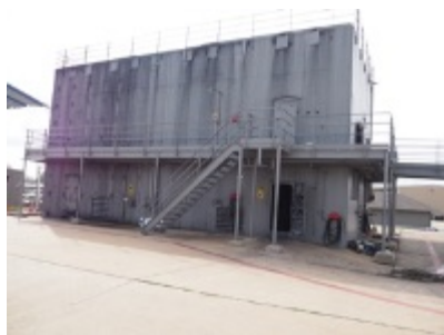
82船舶エンジンルーム火災
