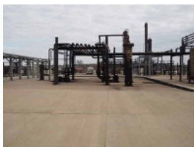
42ポンプ通路火災
