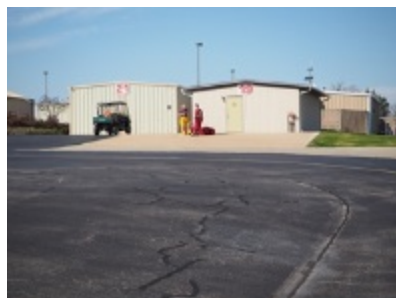
19防火衣等倉庫
