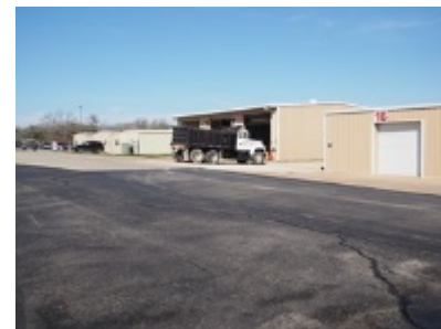
16ポンプメンテナンス室
