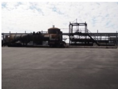
32パイプラック火災
