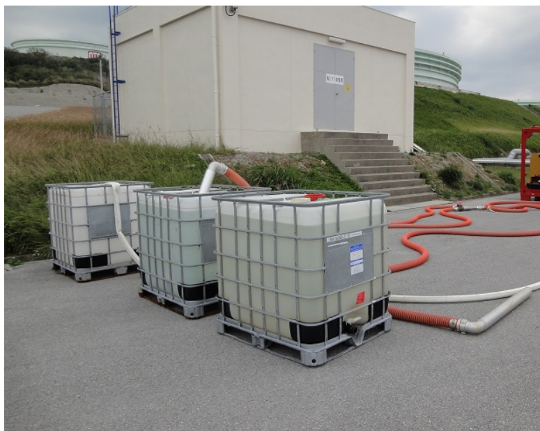
写真 1-3 大容量泡放水砲用泡消火薬剤
