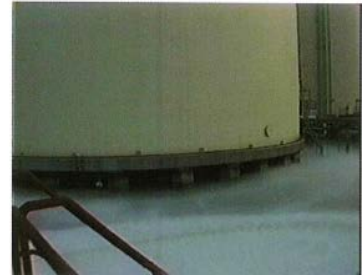
阪神淡路大 震災時のL PG漏えい 状況
