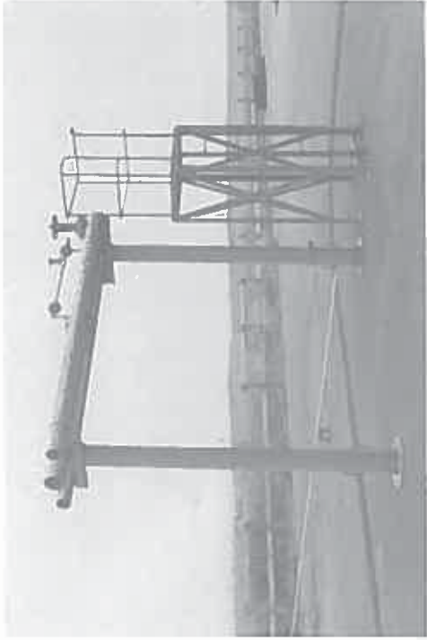
フランジ付き配管 (6B×高さ 2.5m)
