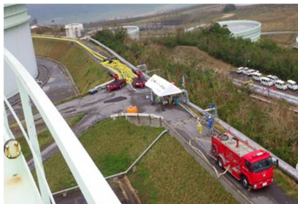
写真 10-4-3 大容量泡放射システムの配置状況
