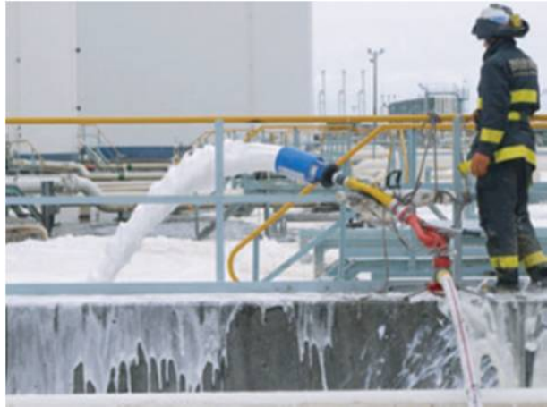
写真 10-3-5 消防隊による泡パージ
