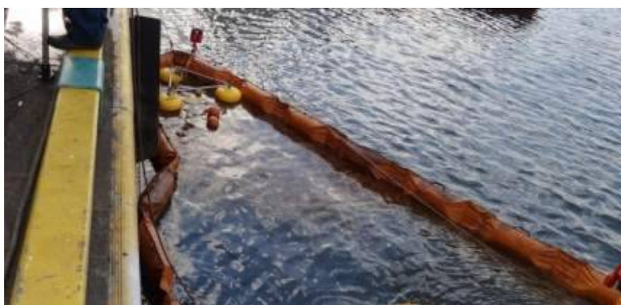
図 7-11-5 油回収装置による油回収
