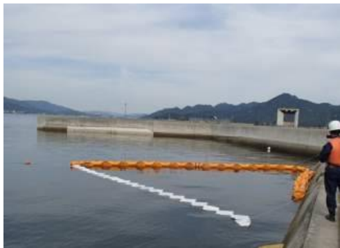
図8-8-8 万国旗状吸着材とオイルフェンス直線展張
