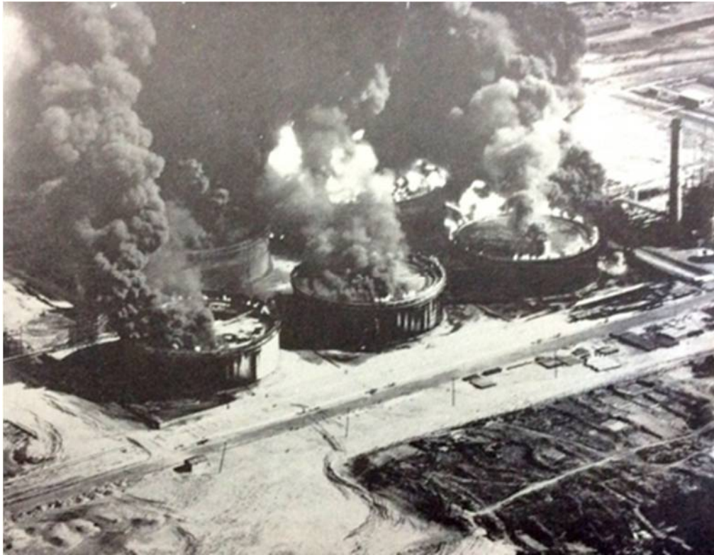
（昭和39年 新潟地震 危険物タンク群の火災状況）
