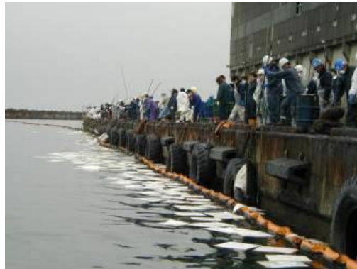
図8-8-7 マット状吸着材の誤った使用例
