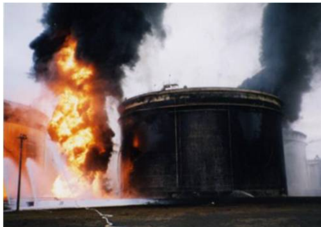
写真 10-1-2 原油タンク火災
