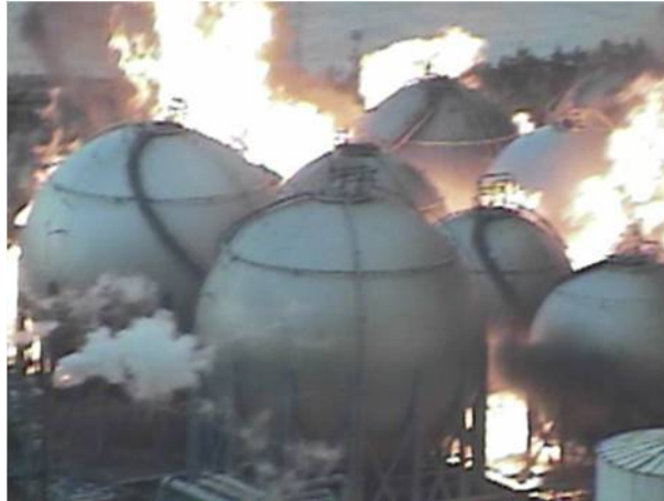
写真 10-2-2 364 番タンク 火災発生 15 時 46 分頃の状況
