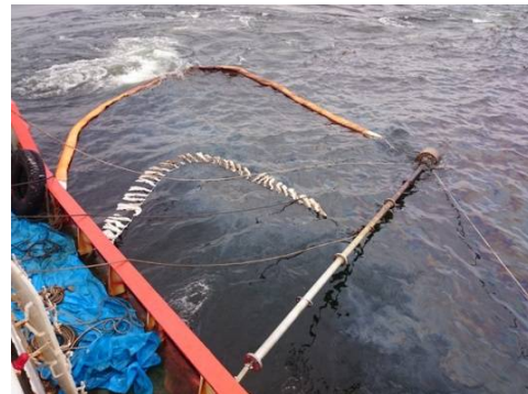
図8-8-9 吸着材フェンスと吹流し状吸着材による油膜の回収
