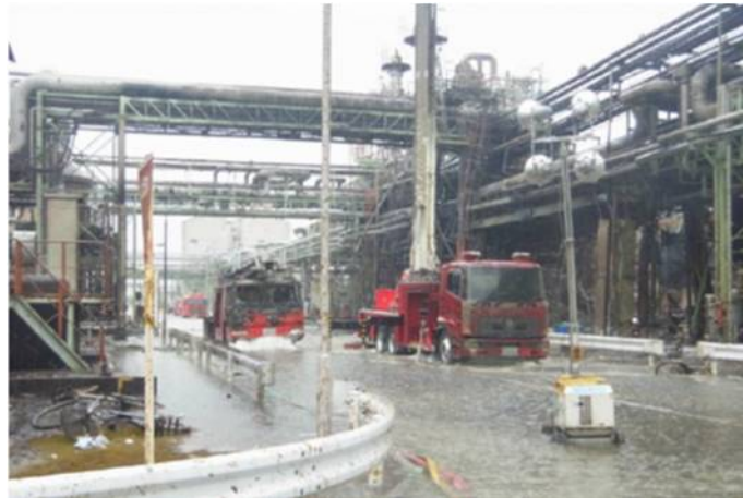
写真 10-2-4 焼損した消防車
