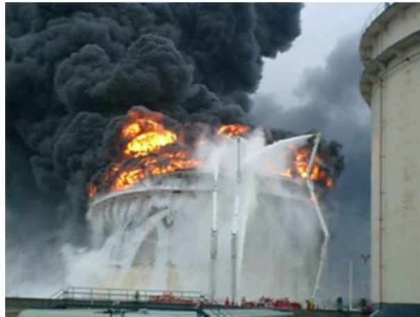
写真 10-1-3 ナフサタンク火災
