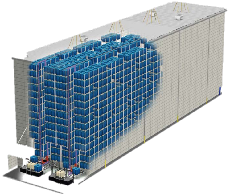
ビル式ラック式倉庫の外観
