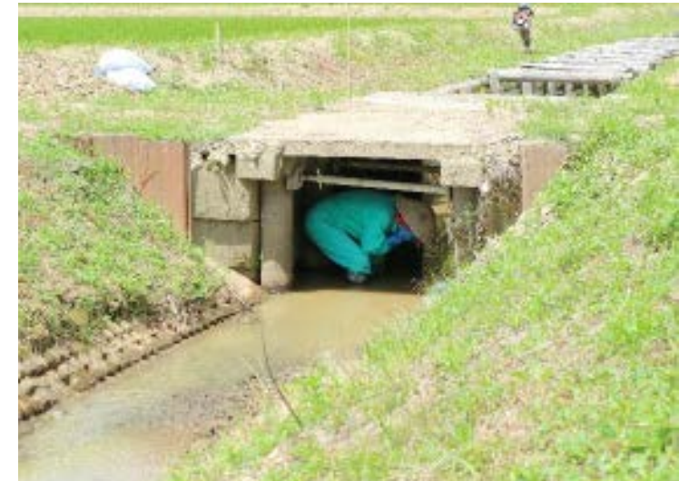
用水路の橋の下に避難する参加者
