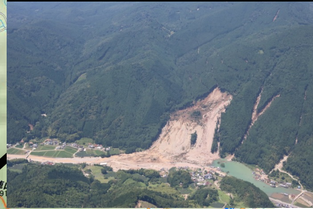
斜面崩壊と小野川の閉塞
