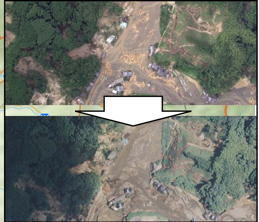
赤谷川流域 流木堆積状況と、処理状況
