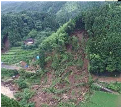
国道211号線 斜面崩落 (7/14 仮復旧済)
