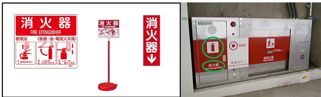
消火器の標識の例
